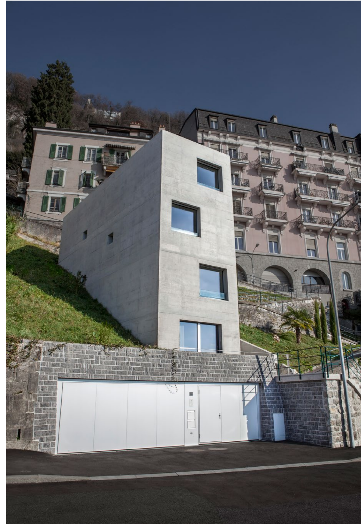
General view Allgemeine Ansicht Vue générale
